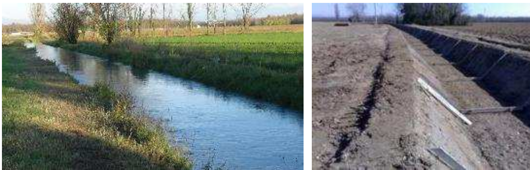
Fig. 2 Canale Santa Maria, 2018, a destra lavori di rifacimento
